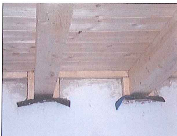
Figura 5 – Particolari di posa del primo assito: lato interno posa di un listello interno a chiusura tra il primo assito e le pareti interne.
