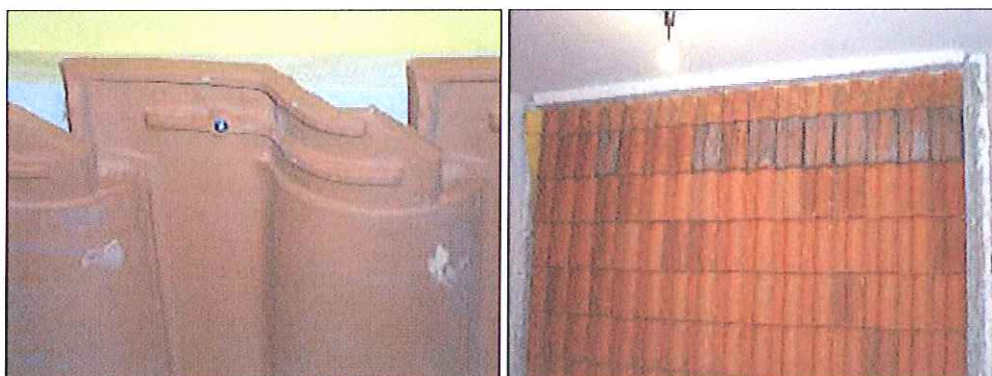
Figura 7 – Particolari di posa e ancoraggio delle tegole in verticale.
