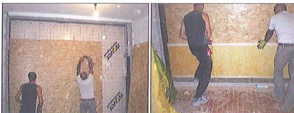
Figura 4 – Posa del primo OSB e posa del primo strato del campione in prova: ISOVER BAC CF N Roofine® posato in doppio strato 60 mm + 60 mm incrociato tra i listelli.
