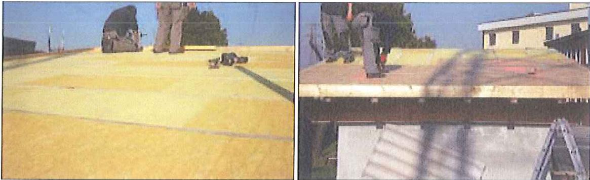
Figura 8 – Particolari di posa della configurazione provata: ISOVER BAC CF N con doppia orditura incrociata e secondo OSB.
