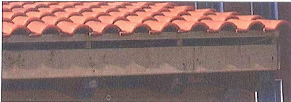
Figura 9 – Particolari della camera di ventilazione
