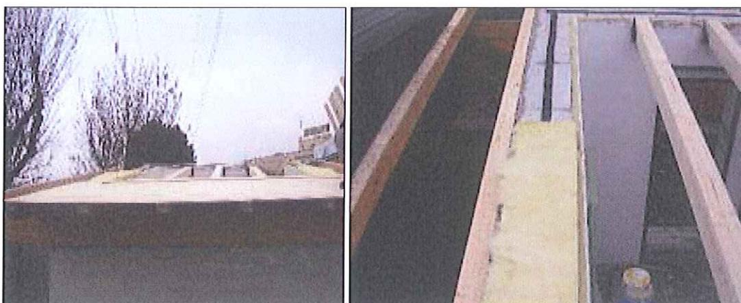
Figura 6 – Particolari di posa del primo assito.
