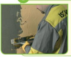
Dopo l'asciugatura completa della seconda mano di rasante, applicare una mano di primer con funzione di ponte di aderenza tra il rasante e il rivestimento (strato di finitura). Dopo l'asciugatura del primer, stendere a spatola il rivestimento in pasta e rifinire a frattazzo.
