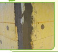
In corrispondenza delle discontinuità di facciata (angoli, sommità, aperture e giunti di dilatazione) è necessario posare prima della rasatura armata i profili di rinforzo e di raccordo. In particolare nei giunti di dilatazione vanno previsti specifici profili o scossaline metalliche, mentre gli angoli vanno rinforzati con appositi paraspigoli in plastica o alluminio.
