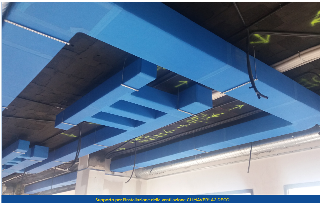
Supporto per l'installazione della ventilazione CLIMAVER® A2 DECO
