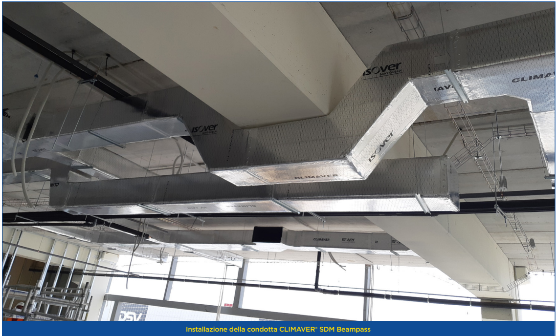
Installazione della condotta CLIMAVER® SDM Beampass
