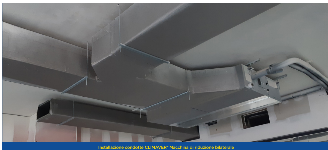
Installazione condotte CLIMAVER® Macchina di riduzione bilaterale
