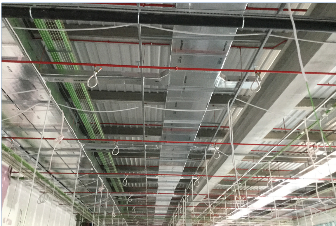
Installazione delle condotte CLIMAVER®
