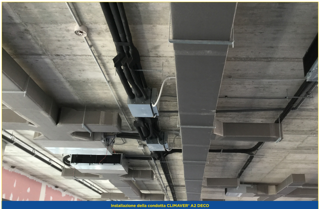
Installazione della condotta CLIMAVER® A2 DECO
