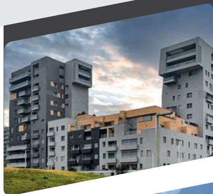
Palazzo Mastino, Verona
