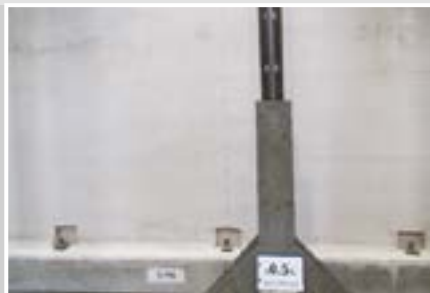
Campione rinforzato, danneggiamento al 0.5% drift
