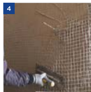
4 Applicazione 2° mano di webertec BTcalceF
