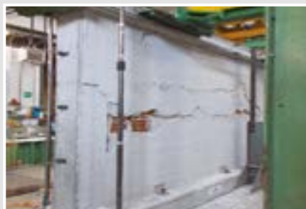
Campione non rinforzato, danneggiamento al 1% drift
