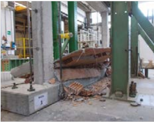
Fine prova a collasso della muratura non rinforzata
