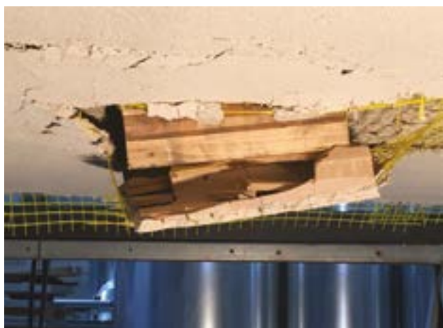
Test con intonaco, rete e tasselli
