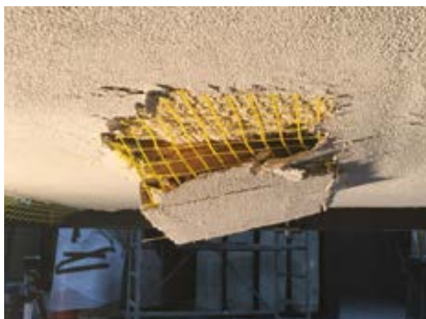
Test con intonaco, rete e tasselli
