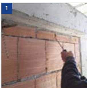
1 Fissaggio connettori in acciaio
