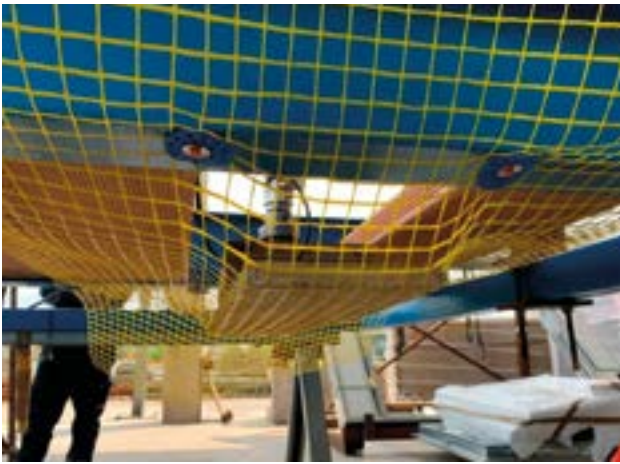
Fase test del sistema con sola rete
