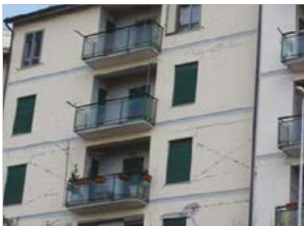
Meccanismo di danno per azioni nel piano - SLD
