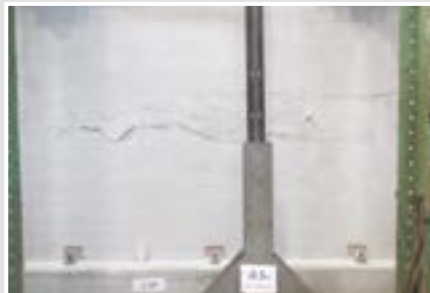
Campione non rinforzato, danneggiamento al 0,5% drift
