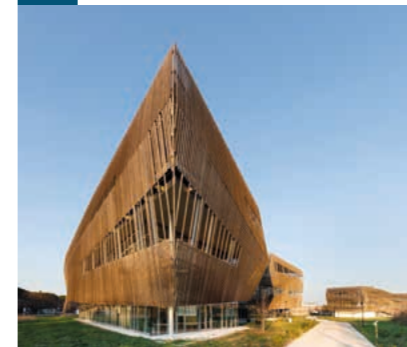
NUOVI UFFICI COMUNALI Ravenna
