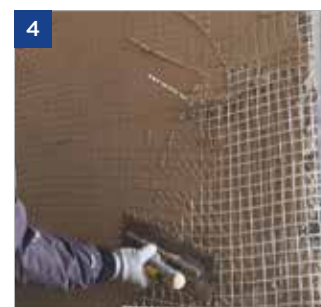
Applicazione 2° mano di webertec BTcalceF
