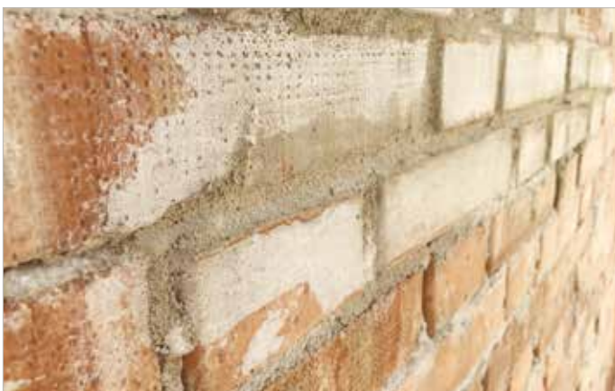
Fasi ristilatura armata per ricucitura lesioni
