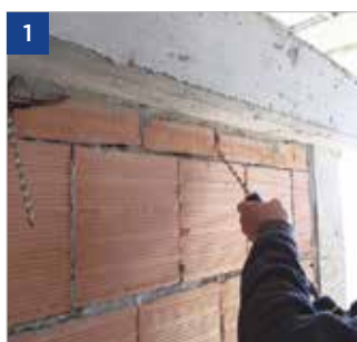
Fissaggio connettori in acciaio
