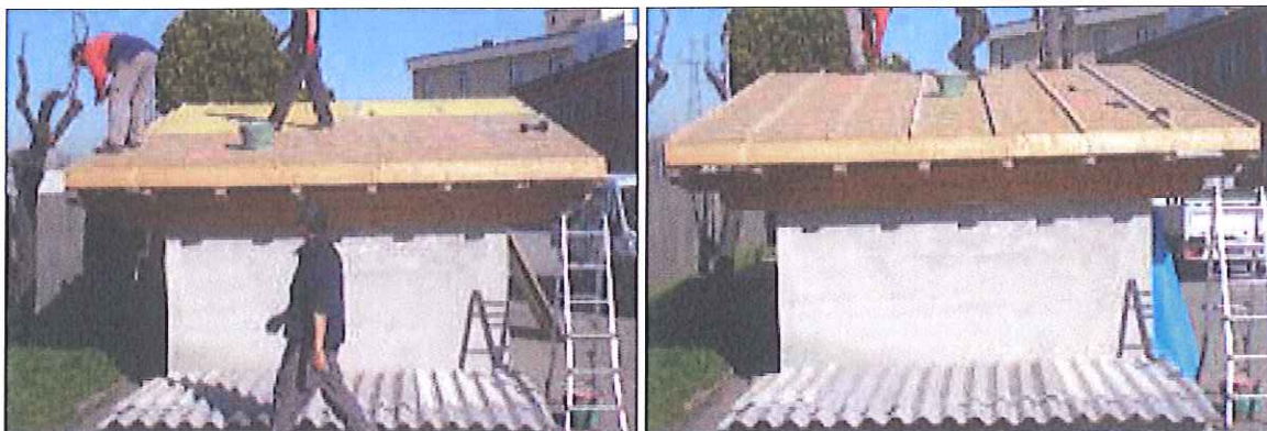
Figura 9 – Posa secondo OSB e posa del listello di ventilazione.
