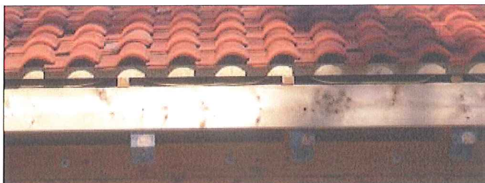
Figura 11 – Particolare della camera d'aria.
