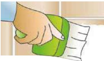
Prima di iniziare le operazioni di posa in opera delle lastre, è necessario verificare che i muri di supporto siano sani, asciutti e non pulvirolenti. Muri pulvirolenti o trattati con disarmante potrebbero compromettere la presa degli adesivi. In tal caso è necessario trattare le superfici dei muri con prodotti fissativi. In caso di muri vecchi, bisognerà eliminare eventuali parti di intonaco che potrebbero scrostarsi.
