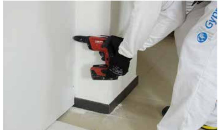
La lunghezza delle lastre deve essere pari alla distanza tra pavimento e soffitto meno 10 mm, da lasciare alla base per facilitarne l'operazione di posa ed evitare il contatto diretto delle lastre con le superfici di base, causa di possibili infiltrazioni di umidità.
