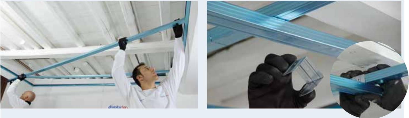
Gli interassi dei profili della struttura metallica primaria e secondaria, e delle relative sospensioni, variano a seconda della tipologia e del numero di lastre in gesso rivestito e del tipo di applicazione.
