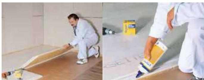
L'adesivo per massetti Rigidur (Nature Line o a base poliuretanic) deve essere applicato sul bordo battentato aperto verso l'alto in direzione della fuga trasversale.
