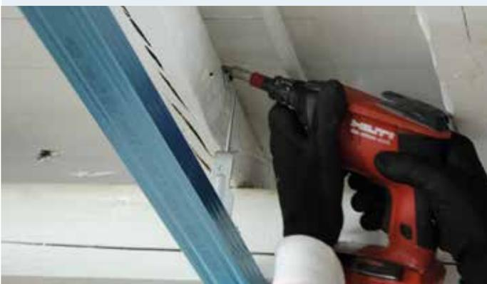
La scelta della sospensione va fatta in funzione dell'abbassamento previsto e del tipo di profilo impiegato; il suo fissaggio deve essere definito in base alla natura del solaio.
