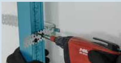
I profili omega, disposti in verticale o in orizzontale ad interasse massimo di 600 mm, saranno direttamente tassellati alla parete di supporto (int. massimo tasselli 600 mm).
